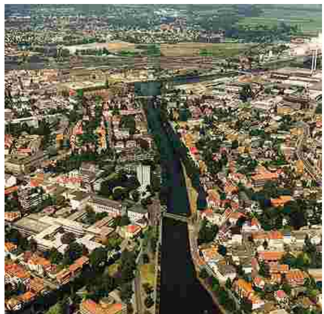
Bild 3. Küstenkanal Stadtstrecke Oldenburg
